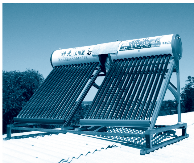
Рисунок 2.31. Солнечный коллектор на крыше дома
