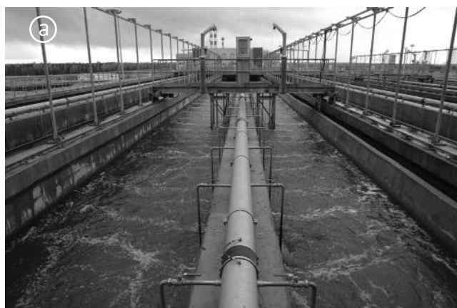
Рисунок 3.12. Очистка сточных вод: а – сооружение для очистки сточной воды с использованием микроорганизмов; б – устройство для подачи воздуха (воздуходувка)
