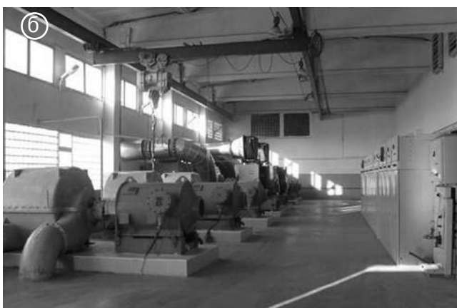
Рисунок 3.12. Очистка сточных вод: а – сооружение для очистки сточной воды с использованием микроорганизмов; б – устройство для подачи воздуха (воздуходувка)
